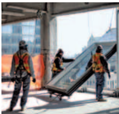
Jede Woche ist ein weiteres der insgesamt 104 Stockwerke des One World Trade Center fertig.
